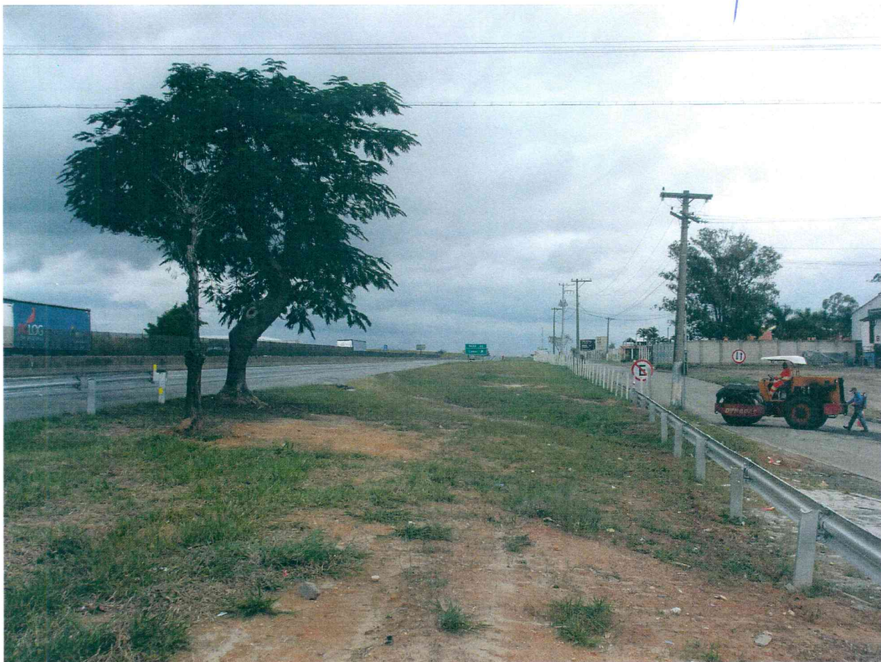
Foto 2: Marginal de acesso a Rodovia Presidente Dutra sentido SP.
