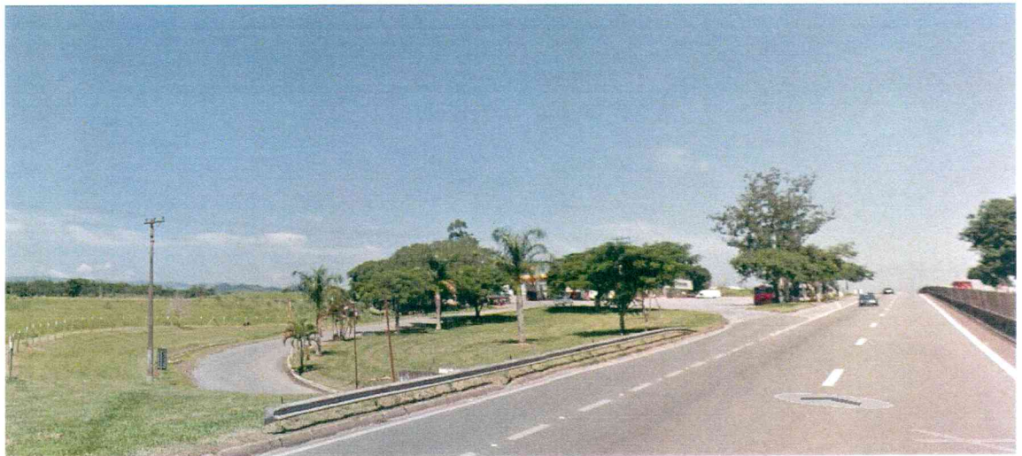
Foto 4: Acesso lateral para túnel sentido Rio de Janeiro da Rodovia Presidente Dutra.
