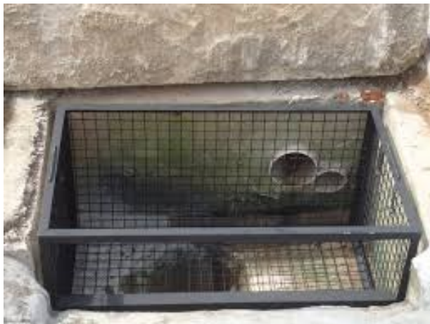
Imagem ilustrativa de um cesto dentro de um bueiro para evitar alagamentos – Fonte: google maps
